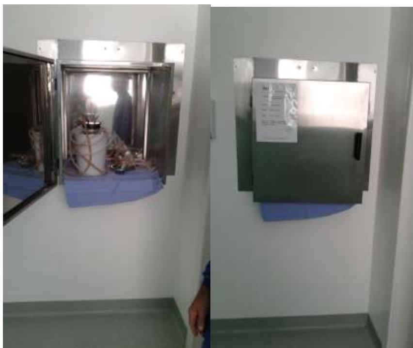
Fotos passagem com porta aberta e fechada. Uma porta por dentro e outra por fora.
