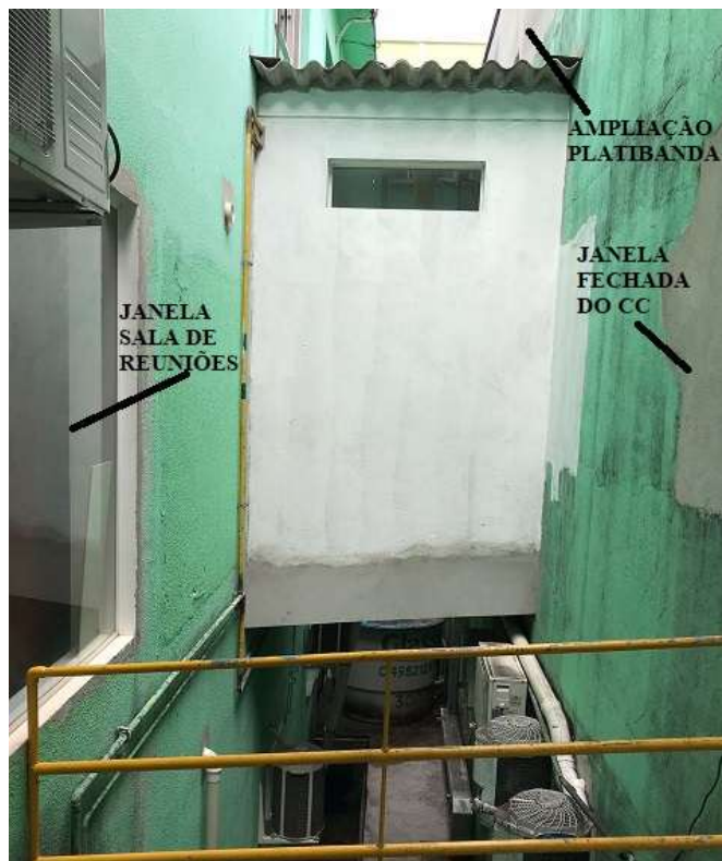
Imagem 6: Fosso de iluminação e ventilação interno. (Autor)
