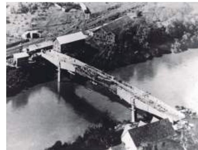
Etapa final de construção da ponte. Deste ângulo, pode-se ter uma noção do desafio de projetar o concreto armado sem sustentação
