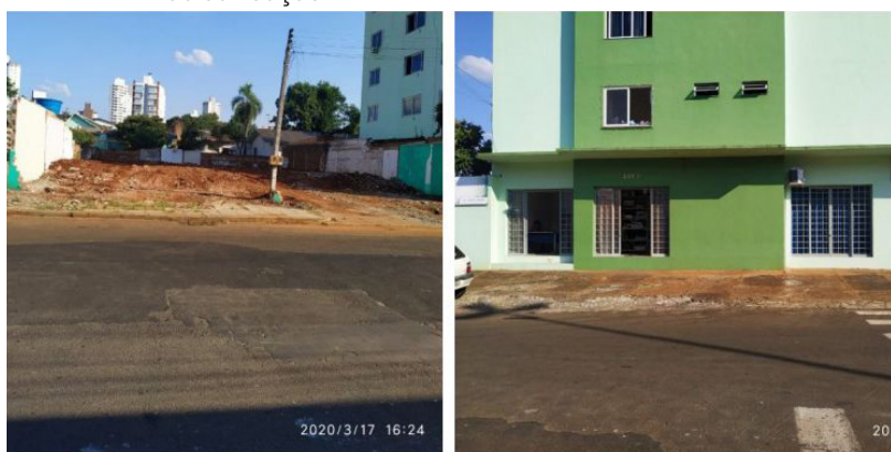
Fotografia 5 – Terreno com nível elevado para que a água não atinja a entrada da edificação
