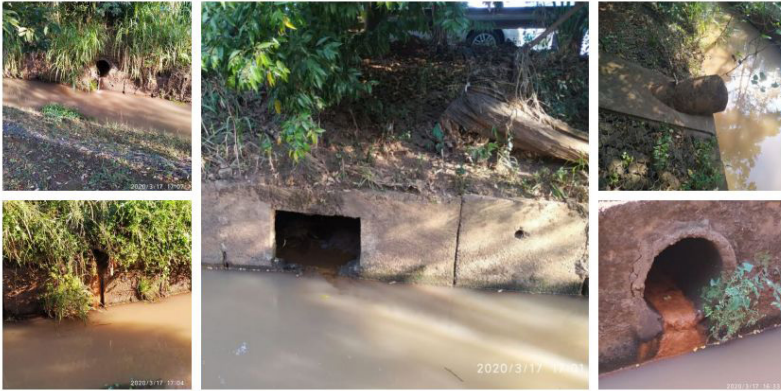
Fotografia 2 – Saída das tubulações das ruas para a Sanga Iracema
