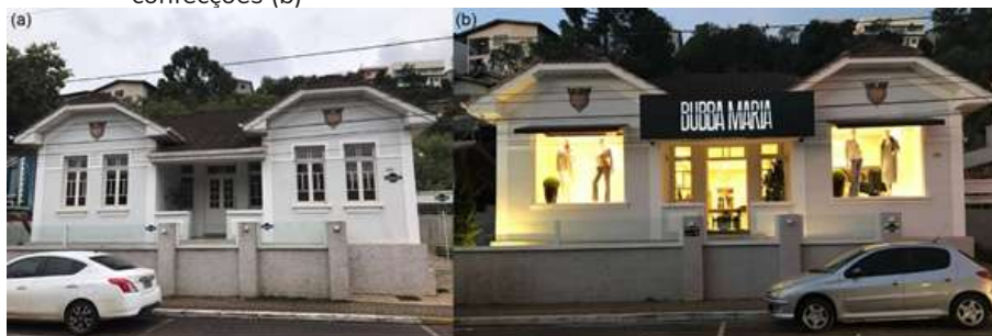
Figura 2 - As modificações da fachada de uma antiga residência ferroviária (a) existente na atual Rua Nicolau Cavon utilizada como comércio de confecções (b)
