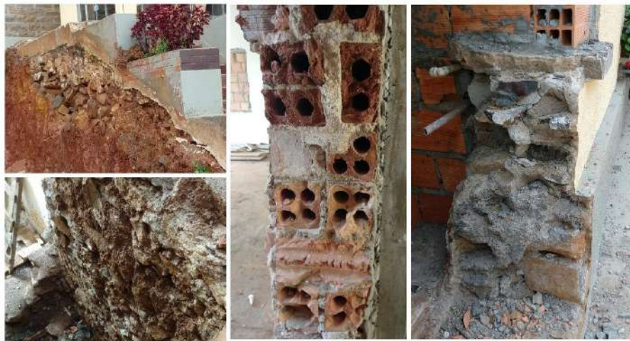
Figura 2 - Base ciclópica e paredes da obra
