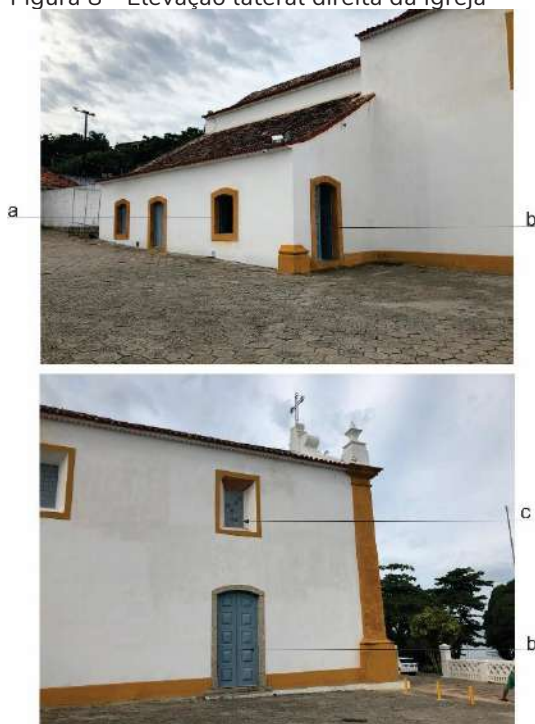
Figura 8 - Elevação lateral direita da Igreja
