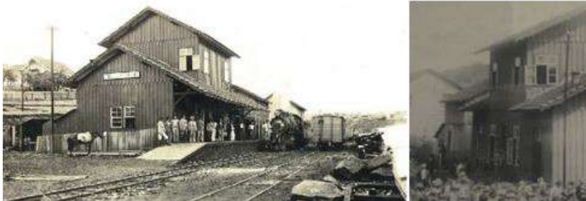
Figura 9 - Fachadas da estação ferroviária Rio Caçador
