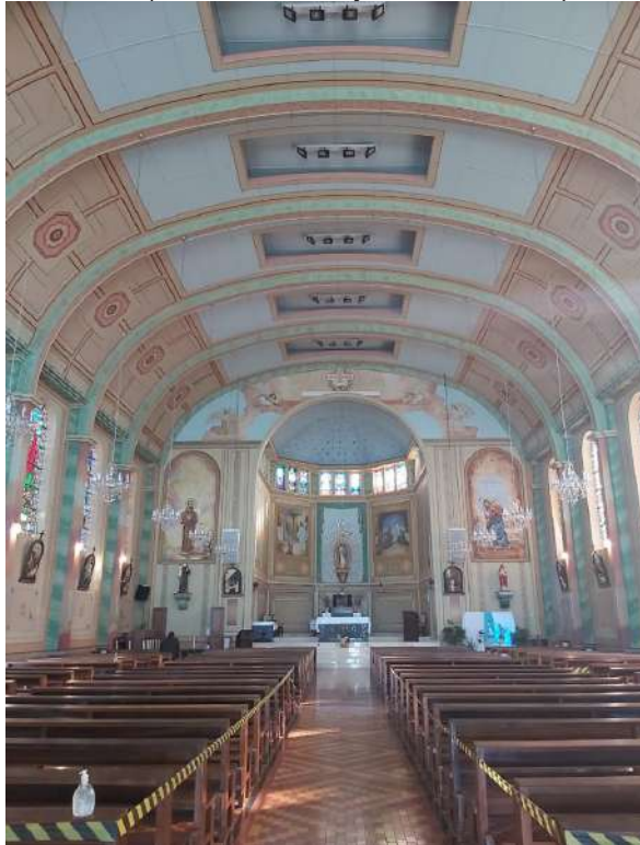
Figura 4 - Nave central única com abóbada de arco abatido e nervuras que se apoiam a pilares com cornijas embebidos à parede
