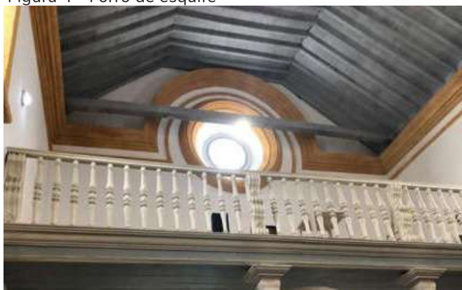
Figura 4 - Forro de esquite
