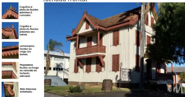
Fotografia 3 - Descrição dos elementos constituintes da fachada frontal
