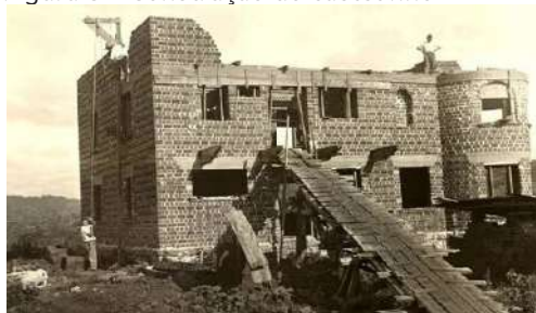
Figura 3 - Construção do castelinho
