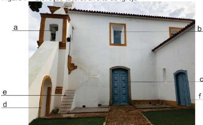
Figura 7 - Elevação lateral direita da Igreja
