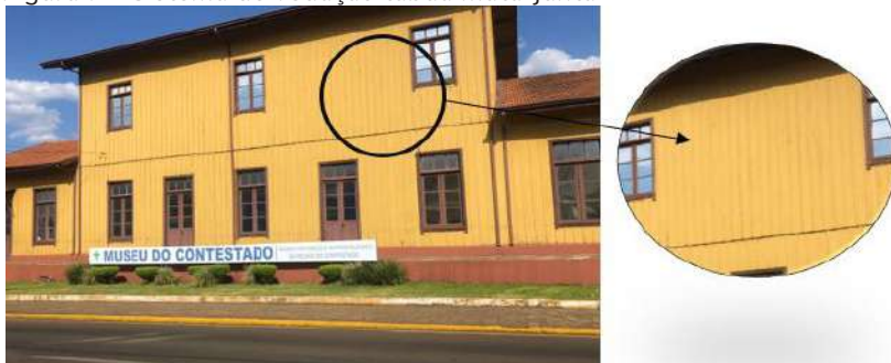
Figura 7 - Sistema de vedação tábuas-mata-junta
