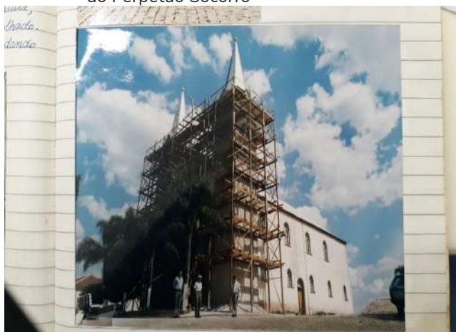
Figura 4 - Restauração da Igreja Matriz Nossa Senhora do Perpétuo Socorro
