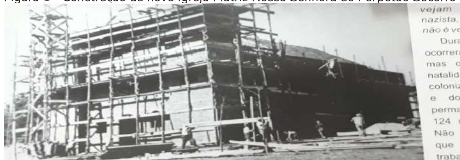
Figura 1 - Construção da nova Igreja Matriz Nossa Senhora do Perpétuo Socorro
