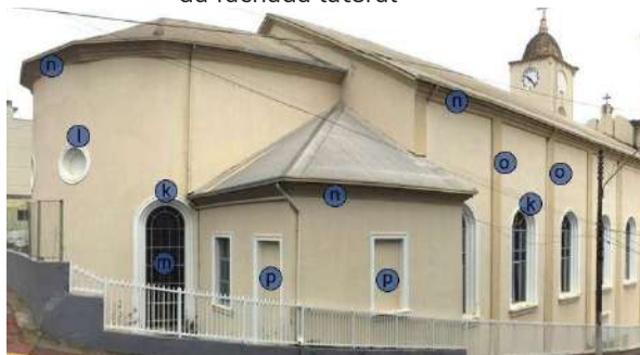
Fotografia 2 - Descrição dos elementos constituintes da fachada lateral
