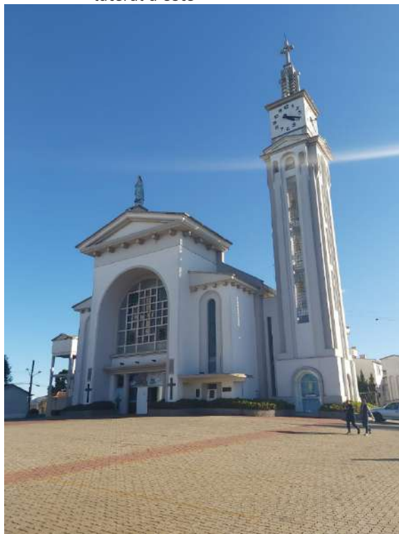
Figura 2 - Fachada principal da obra mostrando o corpo da Igreja e a torre sineira lateral a este
