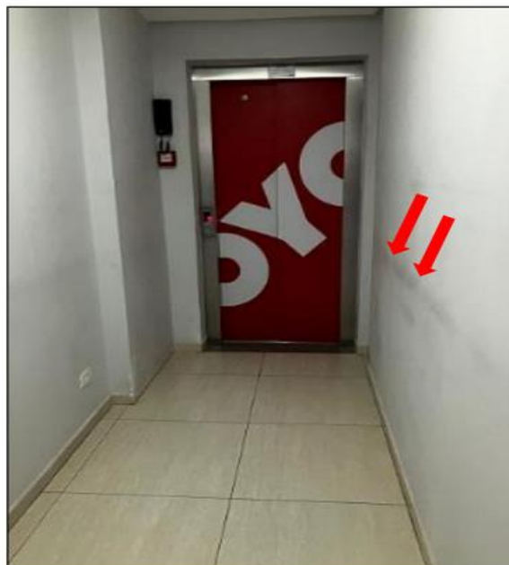
FOTOS 09 e 10: Vista do corredor do pavimento térreo, com acesso para a área de elevador conforme indicado. Nota-se manchas escuras nas paredes. Observa-se sinalização e identificação adequada de portas e equipamentos de incêndio.
